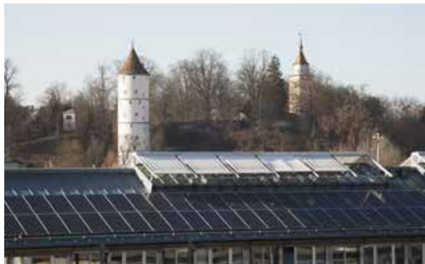
Abbildung 6 Dachflächen Gebäude Campus Stadt
